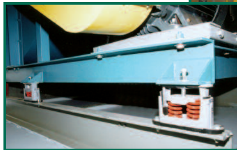
Vibration-Isolation Fan Bases
